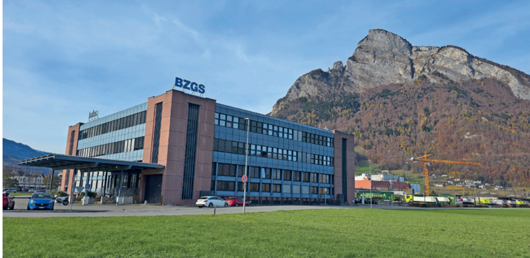
Mit der Kantonsschule Teil des geplanten Bildungscampus Sargans: Das BZBS/BZGS-Gebäude beim Bahnhof Sargans.
